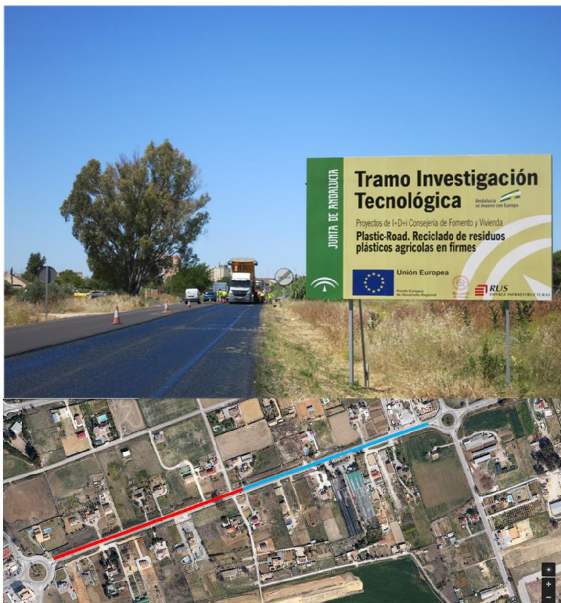
Fig. 8: Tramos AC16 surf convencional (línea roja) y AC16 surf aditiva con plásticos (línea azul)
