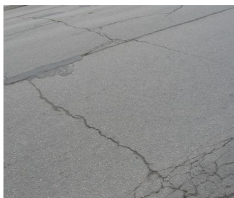
Fig. 2: Diferentes tipos problemas que sufren las carreteras: a) deformación permanente", b) fractura térmica
