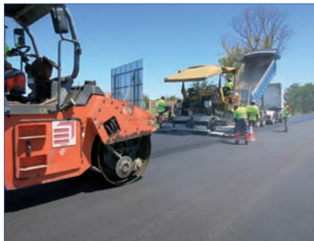
Foto 8. Extendido y compactación de la mezcla betún-polímero en el tramo a escala real.
