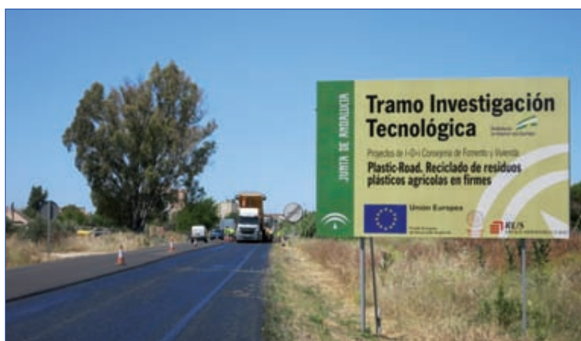
Foto 9. Señalización del tramo experimental.
